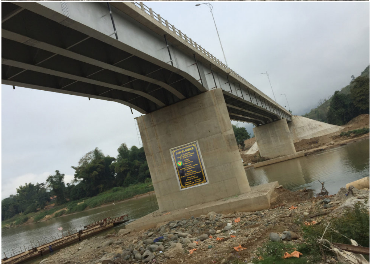
XÂY DỰNG 7 CẦU TRÊN QUỐC LỘ 6A TỈNH HOUAPHAN - LÀO
