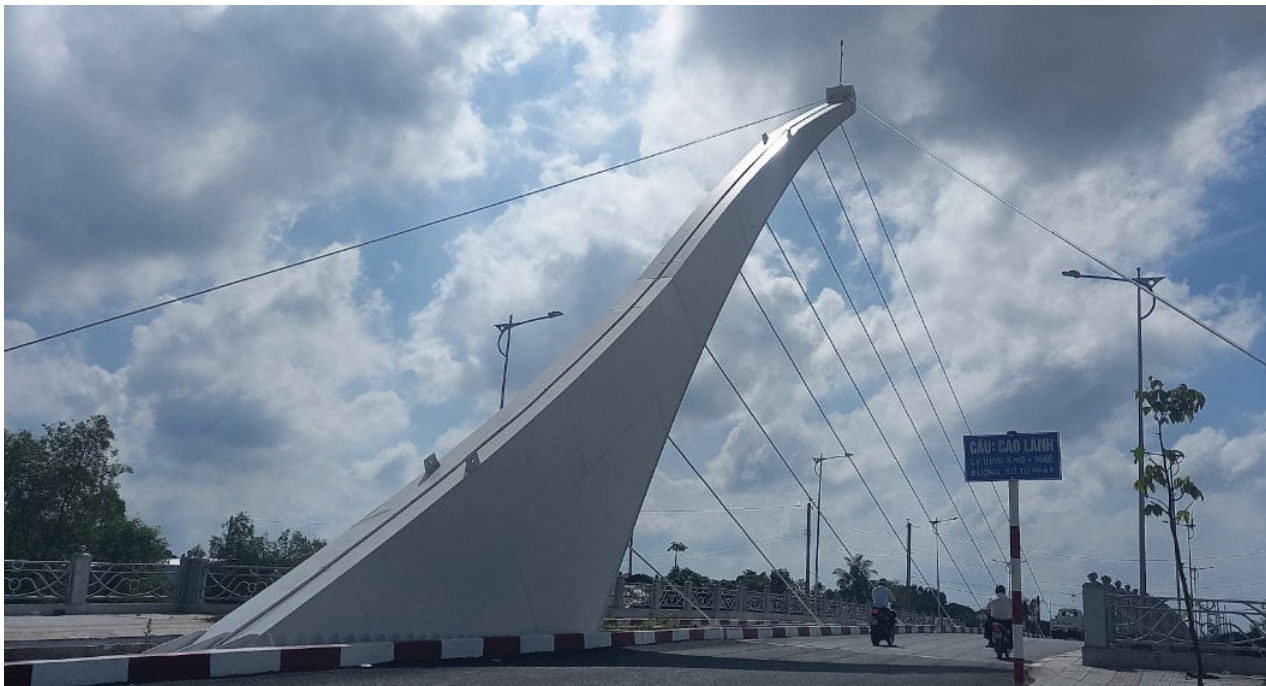
Gói thầu số 10 Xây dựng cầu Rạch Bắp và cầu Cao Lãnh, T. Đồng Tháp
