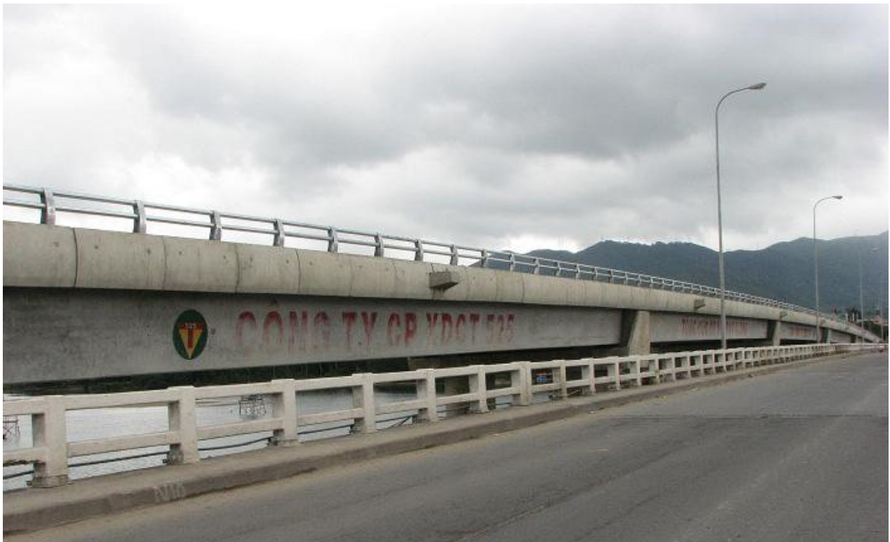
CẦU NAM Ô (KM917+198-QL1) BẮC QUA SÔNG CU ĐỀ THUỘC ĐỊA PHẬN THÀNH PHỐ ĐÀ NẴNG
