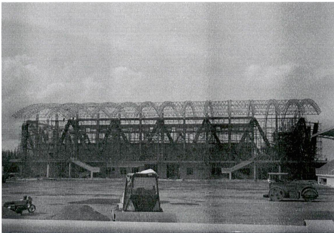
Kết cấu thép Mái nhà thi đấu Đại học Tôn Đức Thắng – TP.HCM
