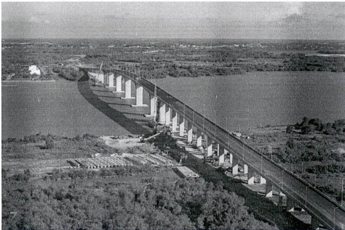
Dự án cầu Nhơn Trạch nối TP.HCM và Đồng Nai trên tuyến Đường Vành Đai 3 TP.HCM
